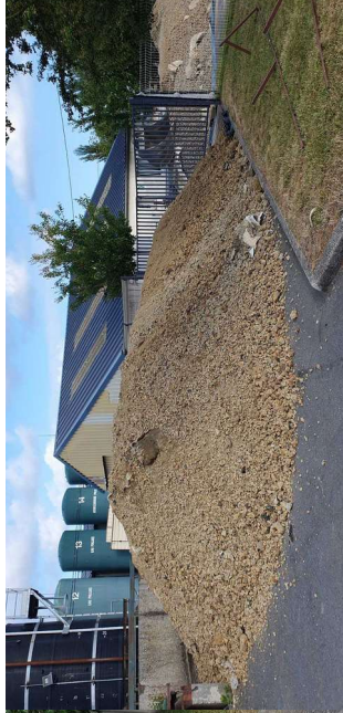
Stockage des remblais de surface a priori non contaminés sur enrobé et bâche sous-jacente.
