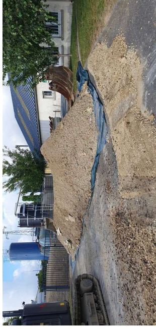
Stockage sur bâche des remblais présentant moins d'impacts en attente des analyses pour évacuation dans les filières adaptées
