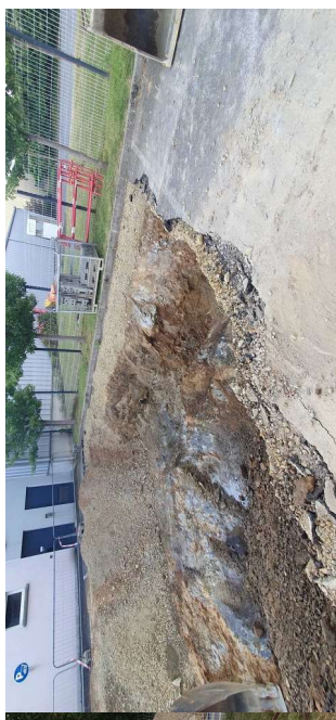
Stockage des remblais les plus contaminés au sein de la fosse d'excavation avant évacuation dans les filières autorisées
